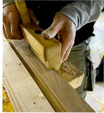
Arbeiten mit dem Handhobel zur Erstellung von Profilen
